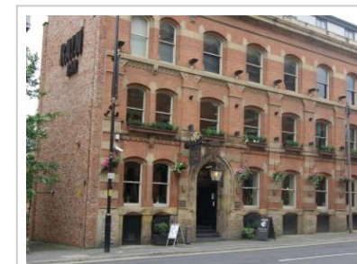
Rain Bar exterior
